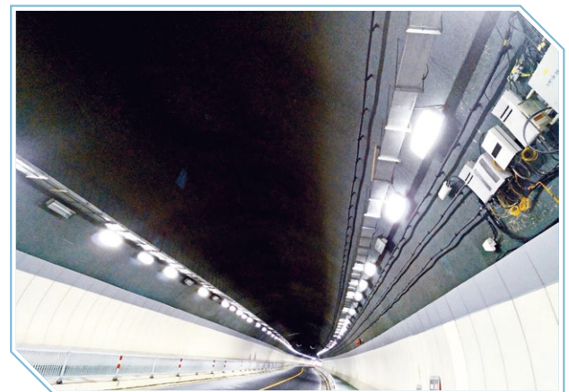
聯合中國聯通推出業內首款 5G 公路隧道貼壁天線
